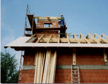
Die Zimmersleute sind noch am Werk.
