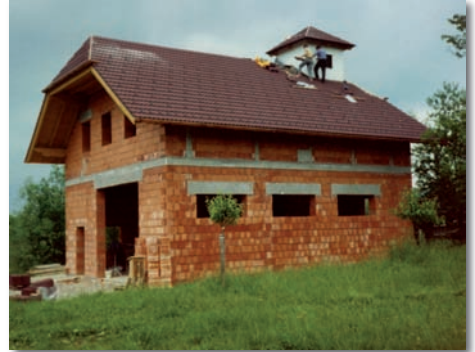
Der letzte Feinschliff am Rohbau.
