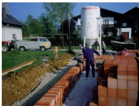
Das Fundament sitzt.
