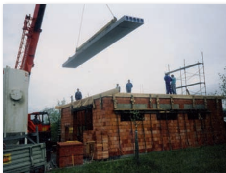
Die Deckensegmente werden positioniert.
