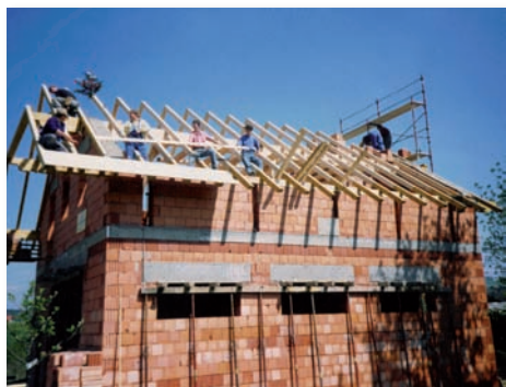
Das Zeughaus bekommt ein Dach.
